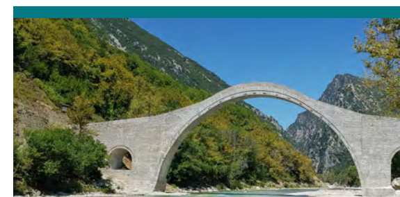
Γεφύρι Πλάκας, στέκει και πάλι όρθιο και περήφανο!
